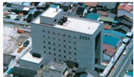
昭和58年7月に完成した新本店の全景
